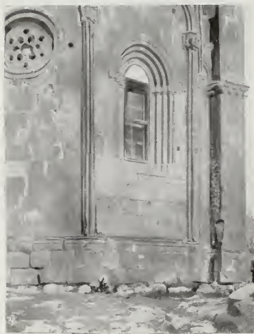
Zuri - Chiesa di S. Pietro (particolari dell'abside).
